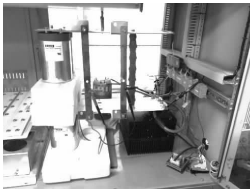
图5 背靠背双功率模块的双脉冲测试实物平台
