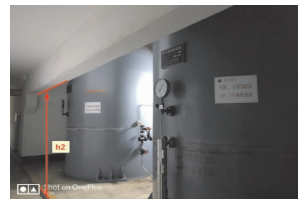
图 2 压力油罐现场安装图
