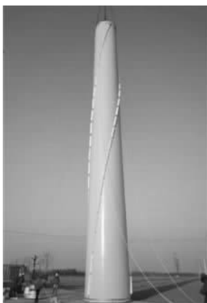
图5 扰流条现场安装图
